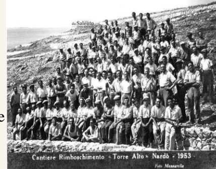
Cantiere Rimboscimento Torre dell'Alto – Nardò 1953
